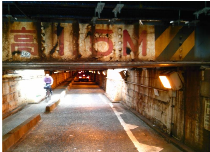
B 東西を結ぶ高さ1.5メートルの「高輪橋梁道橋」のガード下。交通量は意外に多く、タクシー等が次々に通る。
