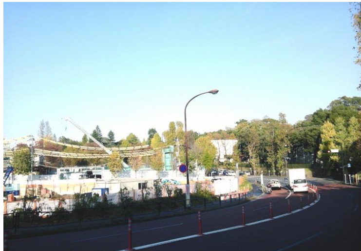
D 迎賓館から神宮外苑へ向かう。右手の木々は東宮御所。御所入口正面(新宿区南元町)で住友不動産によるマンション工事中。
