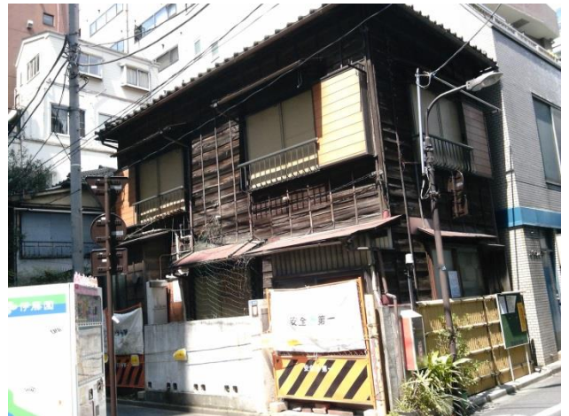
L 取り壊し寸前の木造建築(芝1丁目)。
