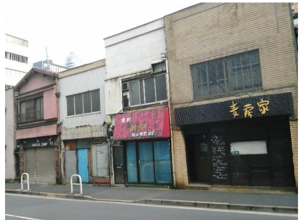
H 取り壊し寸前の店舗。
