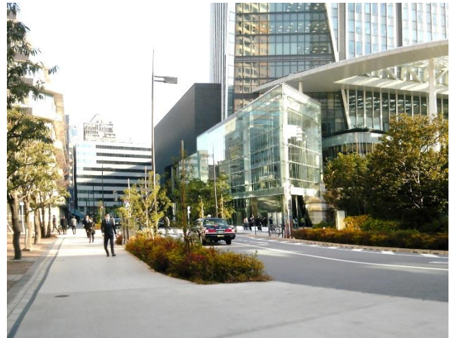
H 虎の門ヒルズの北側の隣接道路
