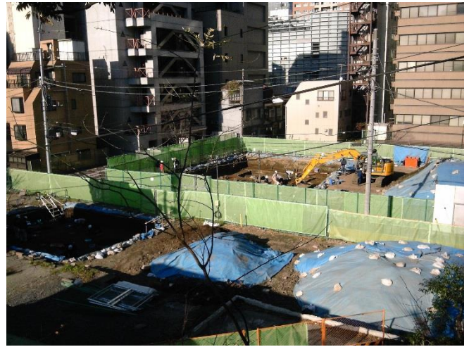
J Iの1帯では工事が始まった。
