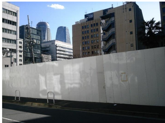
L Kは取り壊され、工事が始まりました。
