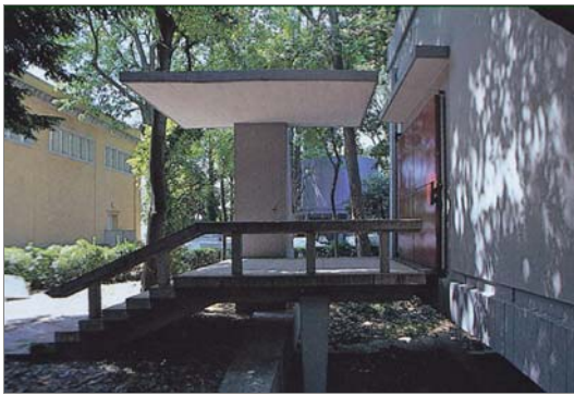
写真2 日本館 入口廻り
