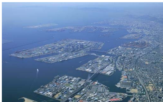
神戸港全景（神戸市 HP より）
