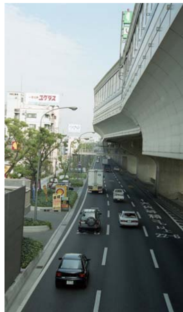
1997 年復旧した阪神高速 3 号神戸線 (阪神・淡路大震災「1.17 の記録」より)
