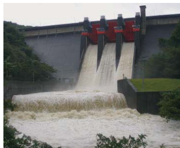
ゲート放流を行う室生ダム
