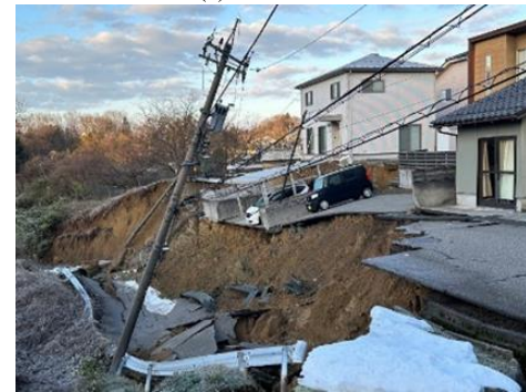
(b)盛土崩壊後
