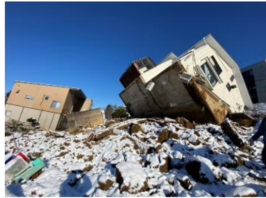
(a)倒壊建物下部からの様子
