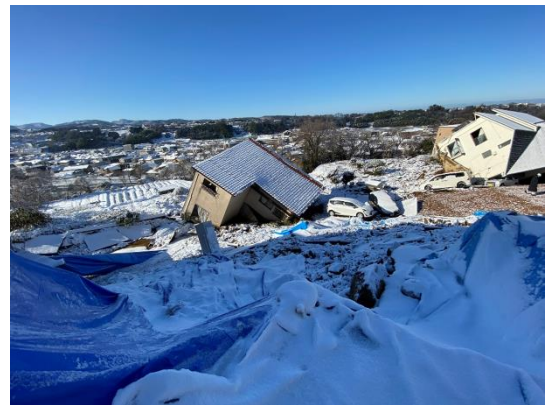
(b)倒壊建物上部からの様子
