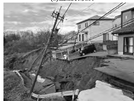
(b)盛土崩壊後
