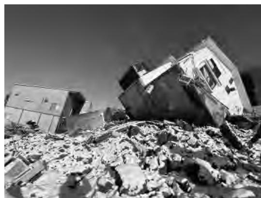
(a)倒壊建物下部からの様子
