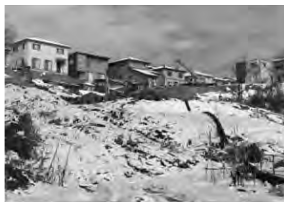
図-15 崩壊盛土末端部の状況
