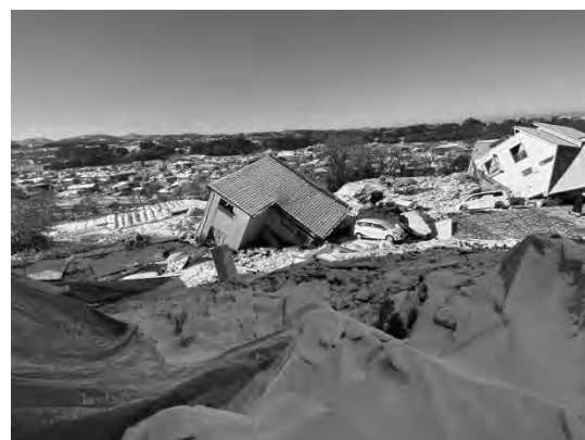
(b)倒壊建物上部からの様子
